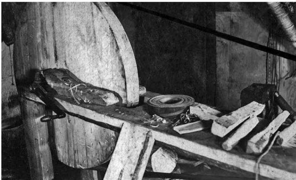
«Солдат-мотор» для привода динамо вручную
