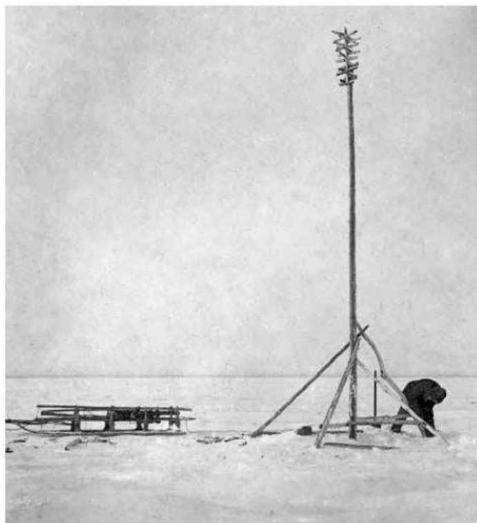
Установка геодезических знаков
