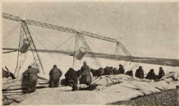
Разборка корабля. Металлический остов. Видны баки для бензина.
