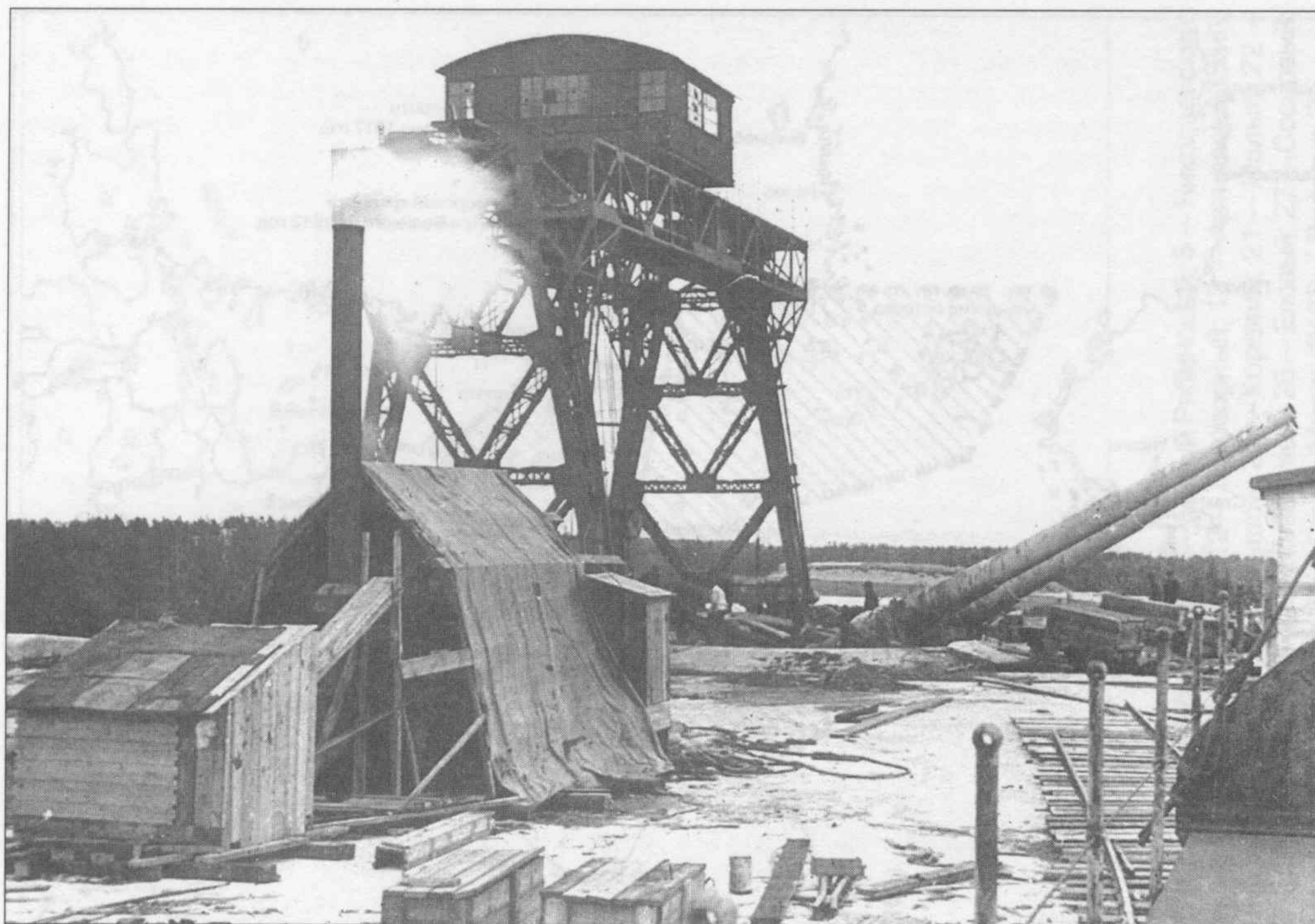
Кронштадтская крепость. Монтаж 305-мм башенной установки на форте «Ино»
