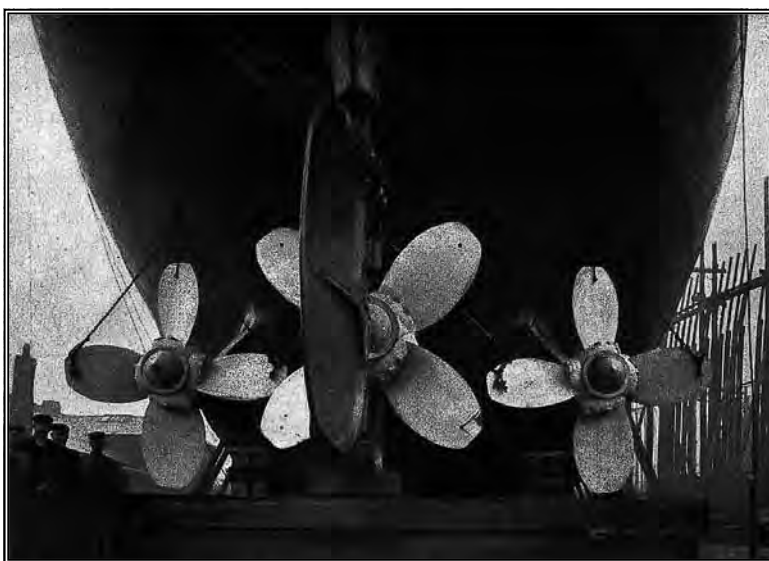
► [ рис. 076 ] «Вид кормовых винтов и руля «Ермака»» (фото из книги Макарова «Ермак» во льдах»)
