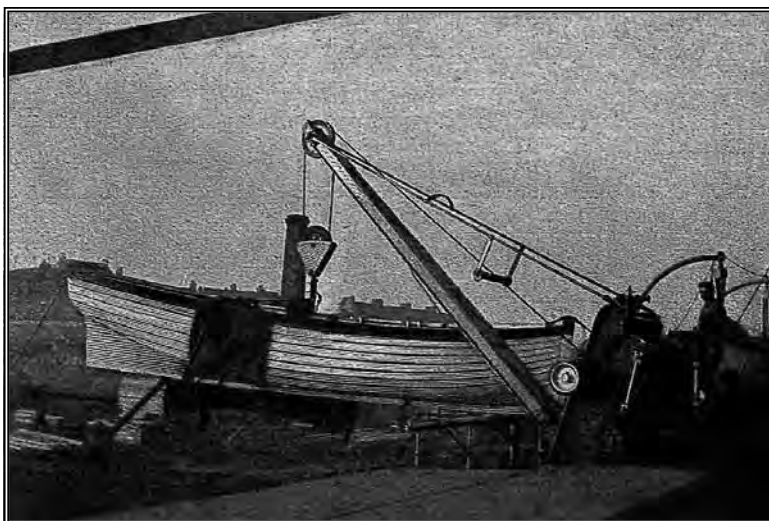
► [ рис. 075 ] «Спуск барказа с запасным якорем на воду» (фото из книги Макарова «Ермак» во льдах»)
