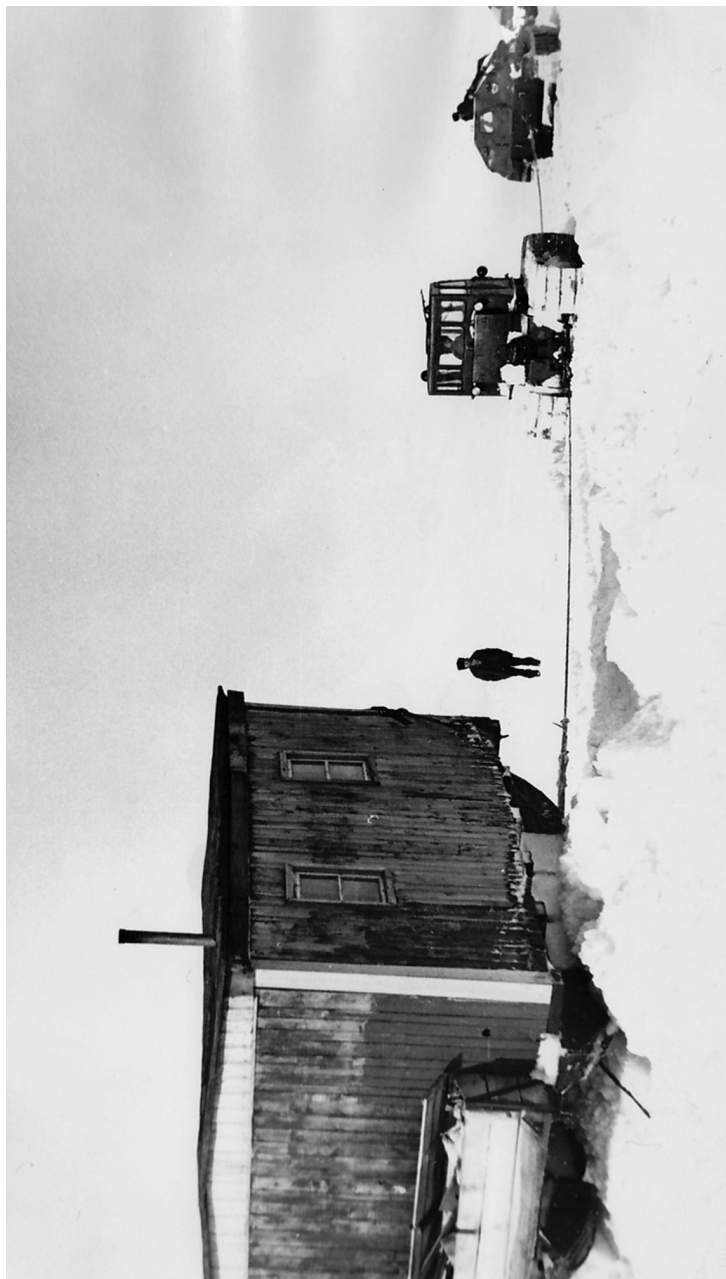
Фото 9. Момент протаскивания балка через глубокую наледь. Один трактор на полуболотных гусеницах был бессилен, пришлось подцеплять ещё 2 ГТТ. На крыше трактора открыт и зафиксирован аварийный люк. Пролив Сенявина. Провиденская гидробаза.
