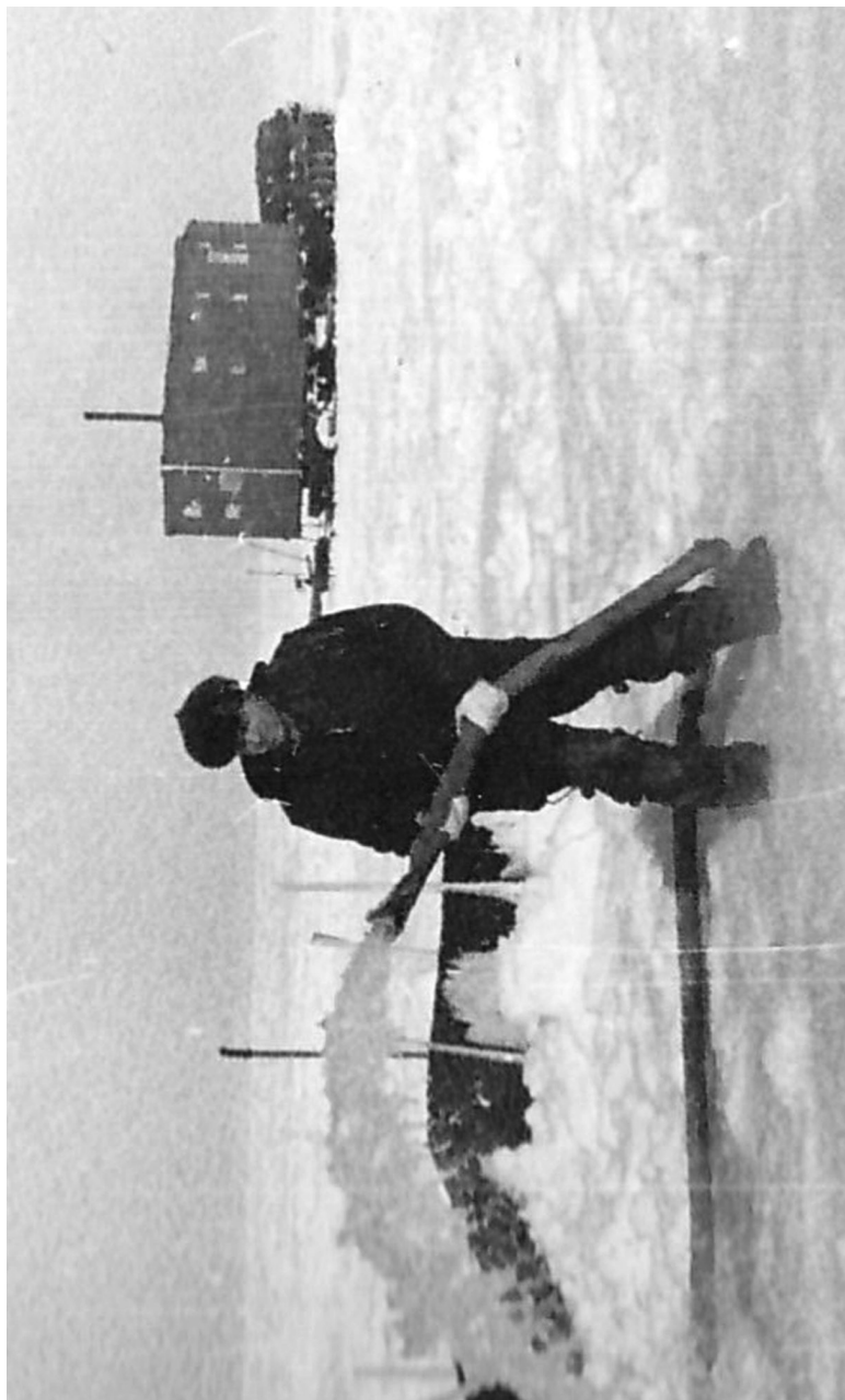
Фото 21. Мощной мотопомпой производится заливка водой ледяного крошева.
