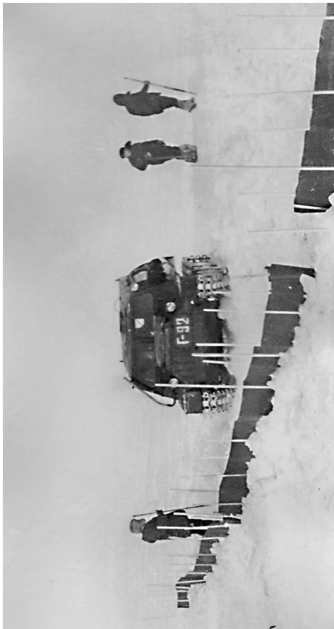
Фото 22. Проверка моста на прочность лёгким вездеходом ГАЗ-47 (4 тонны).
