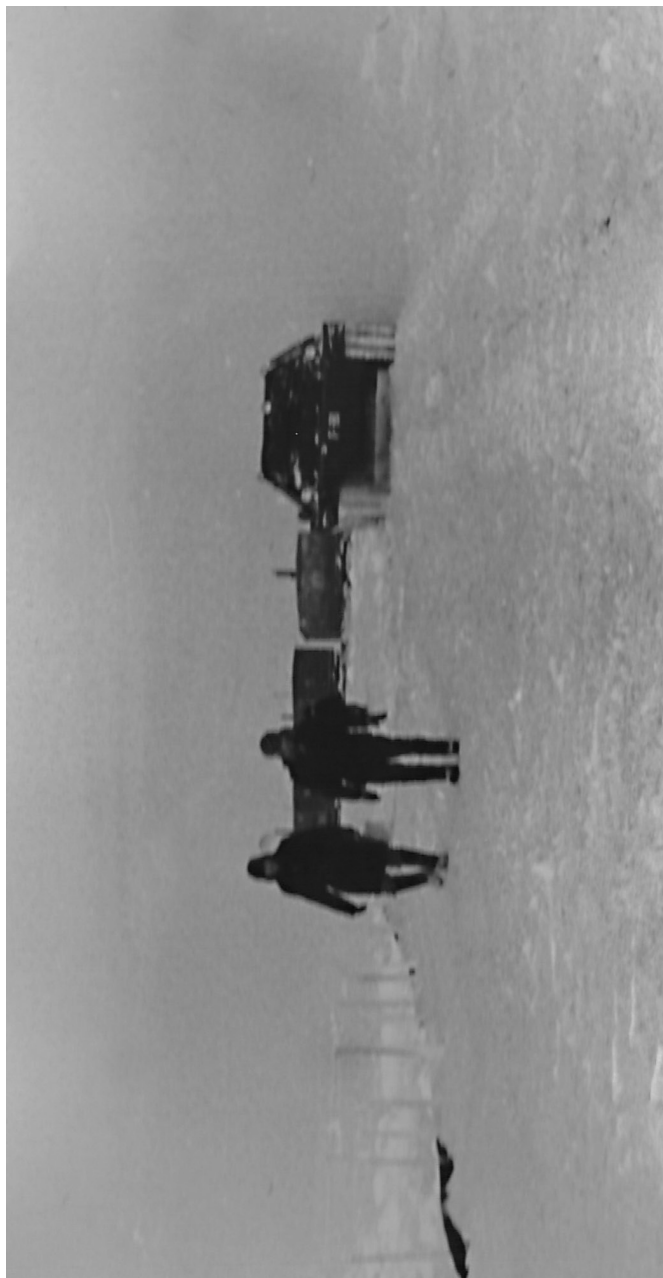
Фото 23. Проверка моста на прочность тяжёлым вездеходом ГТТ (10 тонн).
