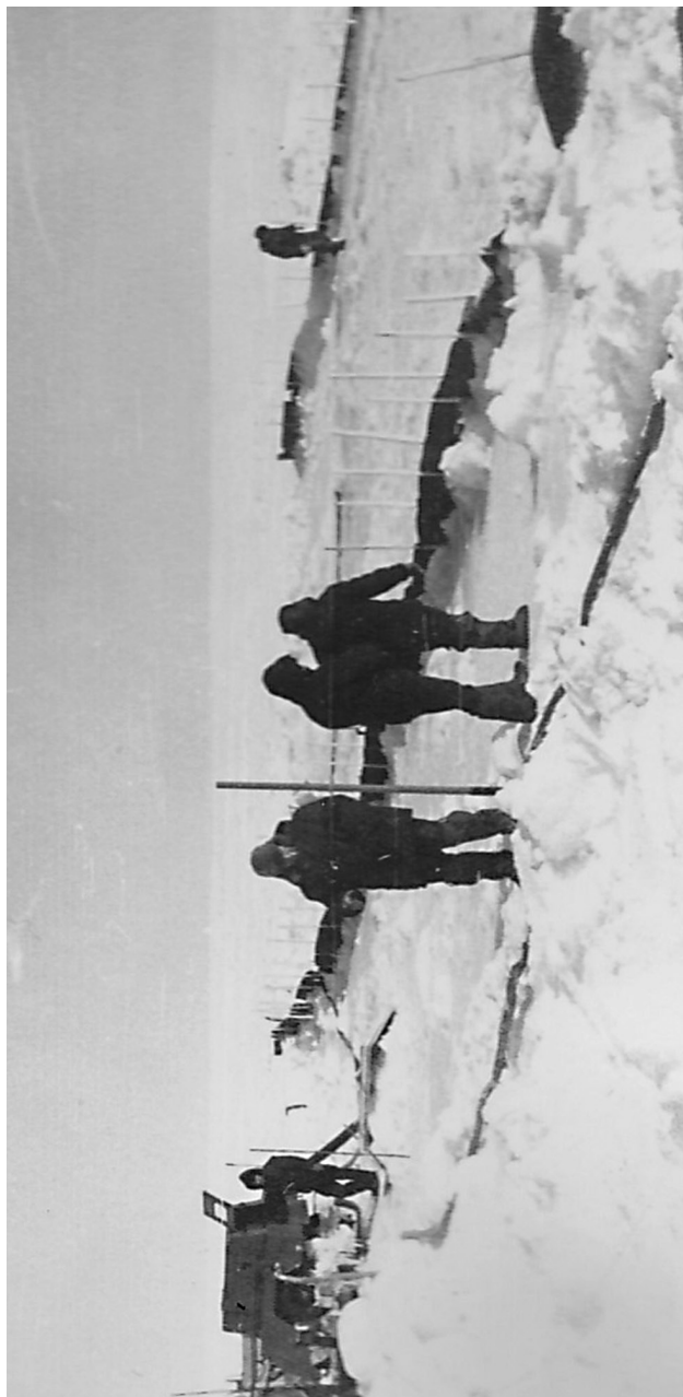
Фото 20. Подготовка к намораживанию ледового моста через ледокольный канал в Енисейском заливе. Срублены торосы, выровнены куски льда, щели засыпаны ледяной крошкой, сделана опалубка из кольев и рубероида, чтобы вода не растеклась.
