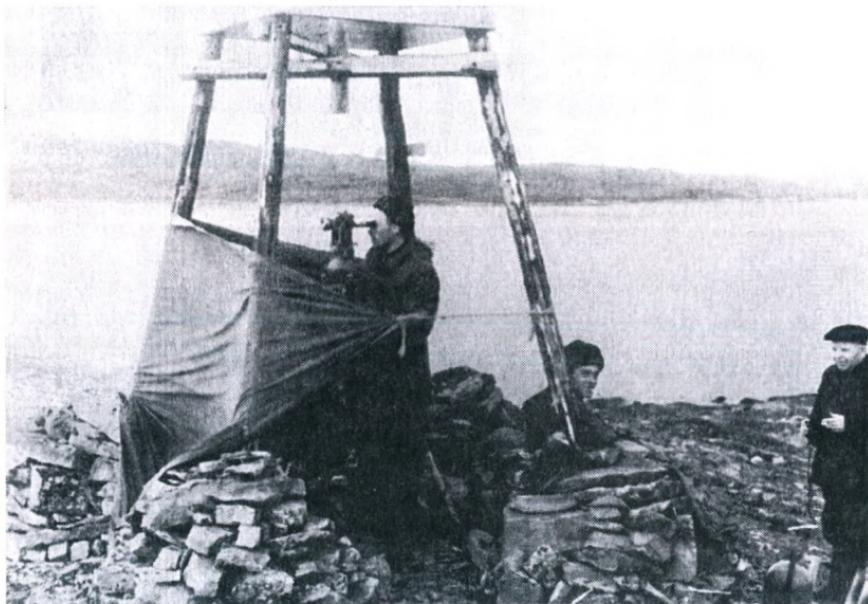
*В.П. Кузнецов на геодезических измерениях
