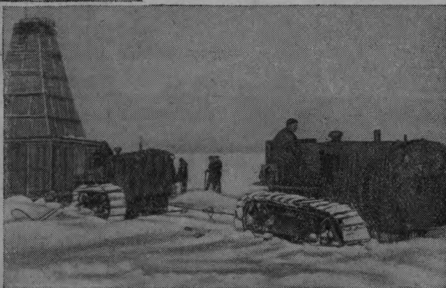
Бухта Угольная. Двумя тракторами перевозят буровую вышку
