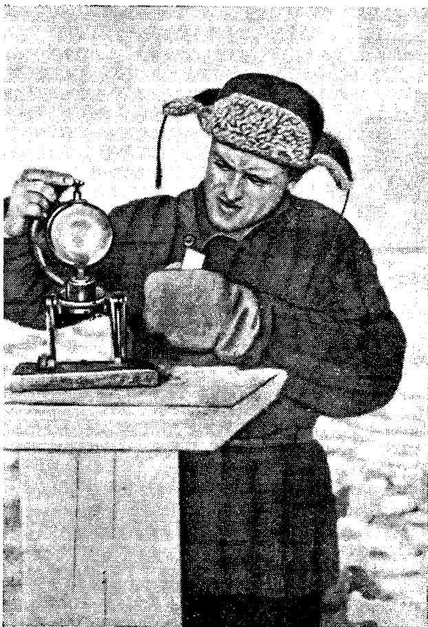
Старший гидрометеоролог полярной станции мыс Желания т. Соколов меняет ленту гелиографа
