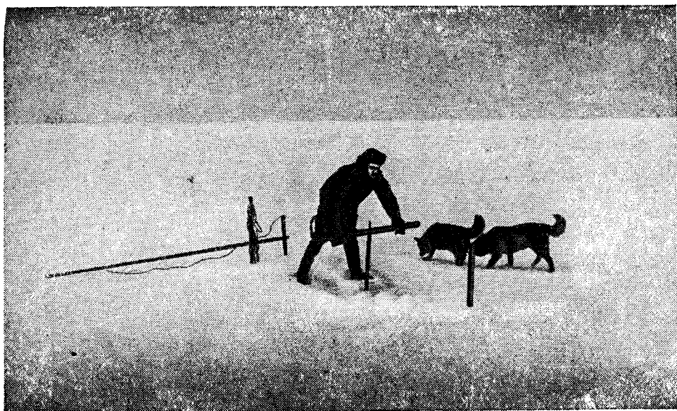
Измерение толщины льда около ледокольного парохода «Г. Седов» весной 1939 г.
