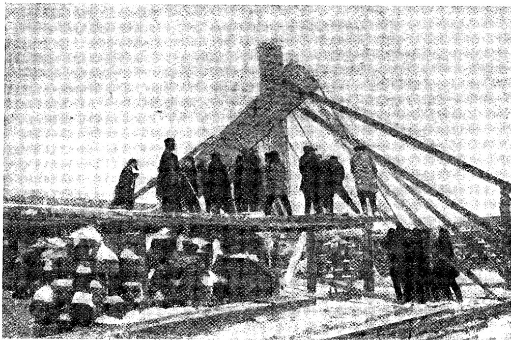
Постановка ахтерштевня для 600-тонной баржи на Придивненской судовой верфи
