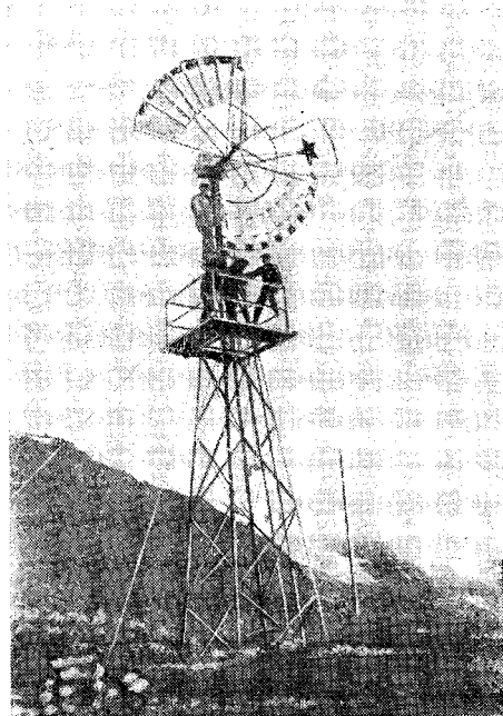
Способ связки шаров для подъема радиозонда (слева). Разборка ветродвигателя в бухте Тихой (справа)
