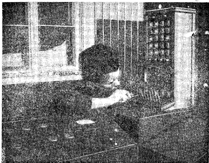
Сборка радиоузла и телефонных коммутаторов (остров Диксона)
