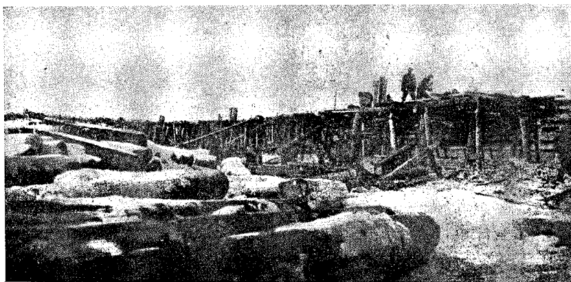
Сборка временной эстакады для загрузки камня в рязь (Порт Игарка).
