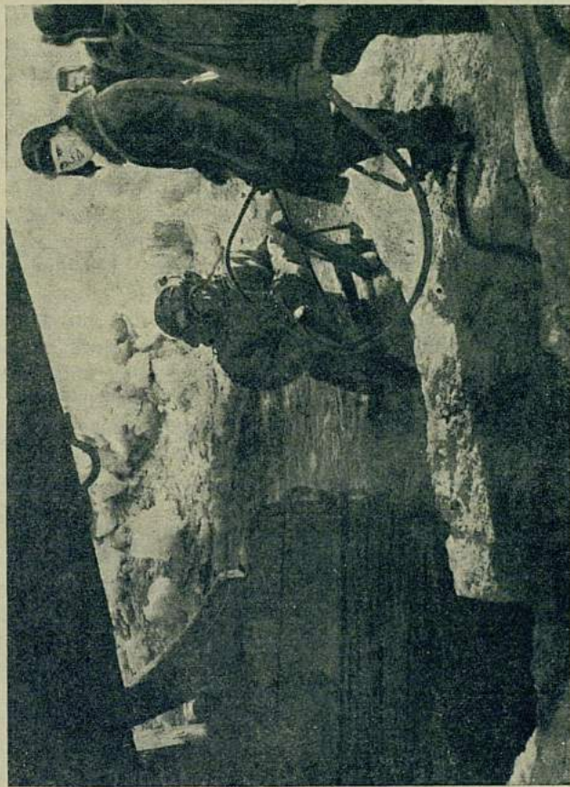
Водолаз осматривает поврежденный в полном море руль
