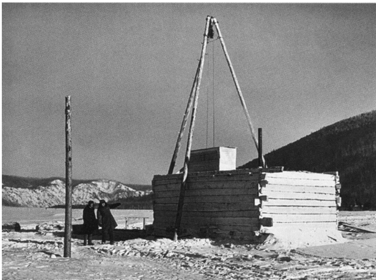
Буровая вышка на льду Шумихинского створа — тут будет начато строительства Красноярской ГЭС. Январь 1956 г.
