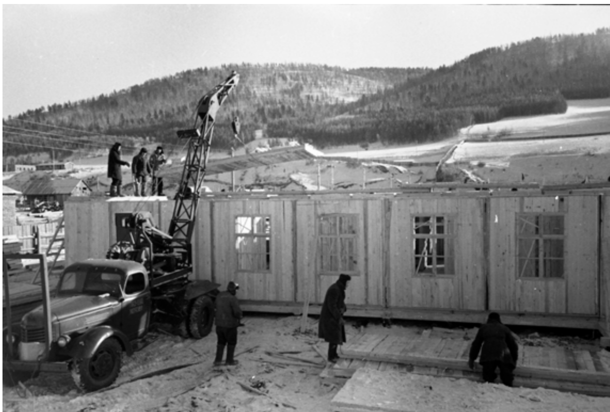
Сборка первых стандартных домов жилого поселка строителей ГЭС. Лалетино, февраль 1956 г. Негатив из фондов КККМ
