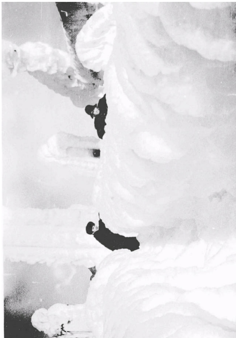
Рис. 6.2-1. Обледенение танкера «Самотлор». Вид на бак с переходного мостика
