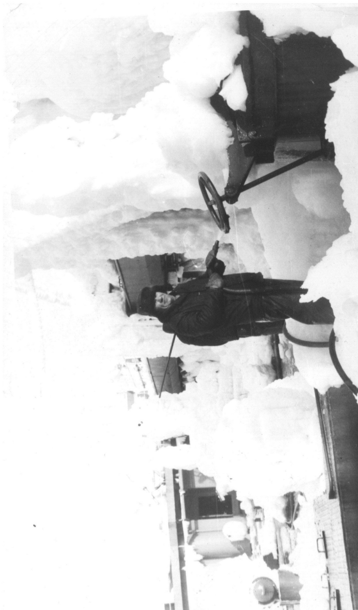
Рис. 6.2-2. Подготовка танкера к разгрузке. Освобождение от льда горловины танкера
