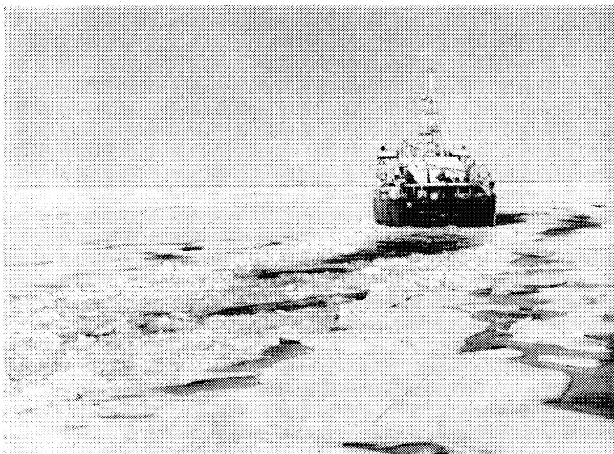
Рис. 65. Канал во льду, проложенный ледоколом. Июнь, Карское море.
