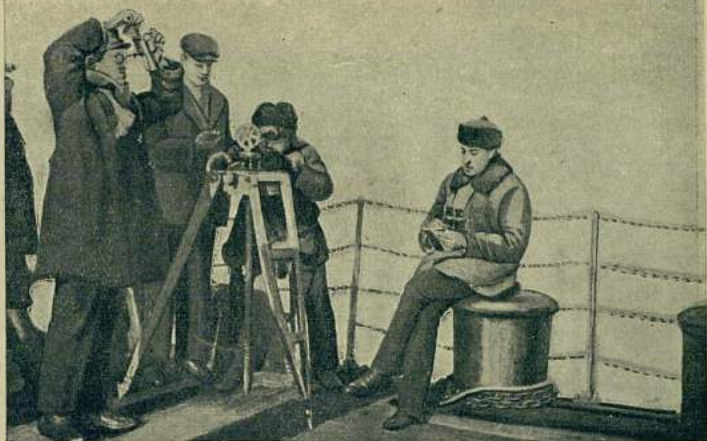
Наблюдают за летящим шаром-пилотом в секстант и теодолит. Слева — начальник экспедиции Н. И. Евгенов.
