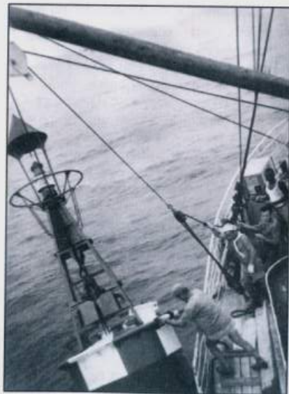
Установка буя на фарватере захода в порт Конакри (Гвинея). Борт гидрографического судна «Вихрь». 1970
