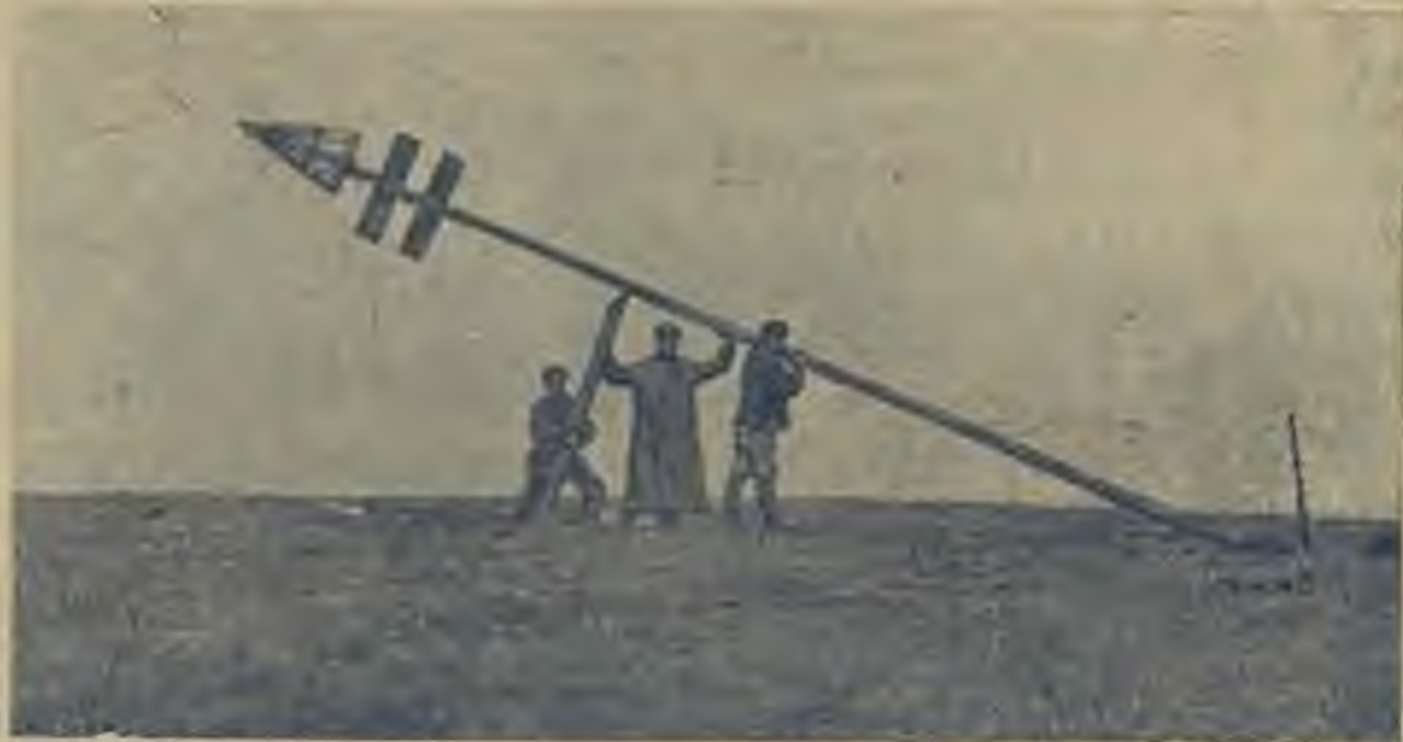
Рис. 71. Постановка промерной вехи на п-ове Явае (1927 г.).
