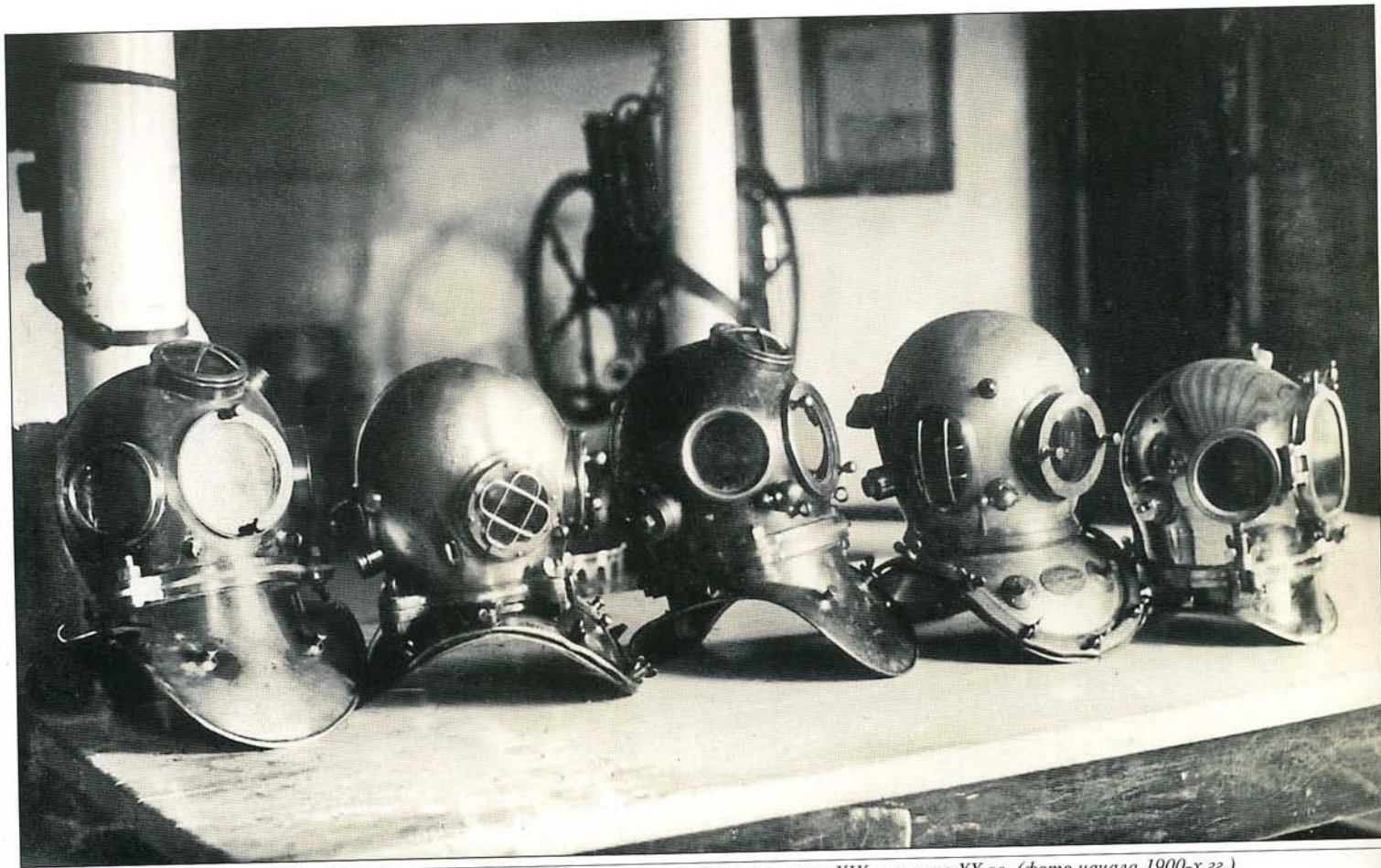
Шлемы вентилируемых снаряжений, использовавшихся в России в конце XIX – начале XX вв. (фото начала 1900-х гг.) The helmets of «free-flow» diving gear used in Russia at the end of XIX – beginning of XX centuries (photo of the early of 1900s)
