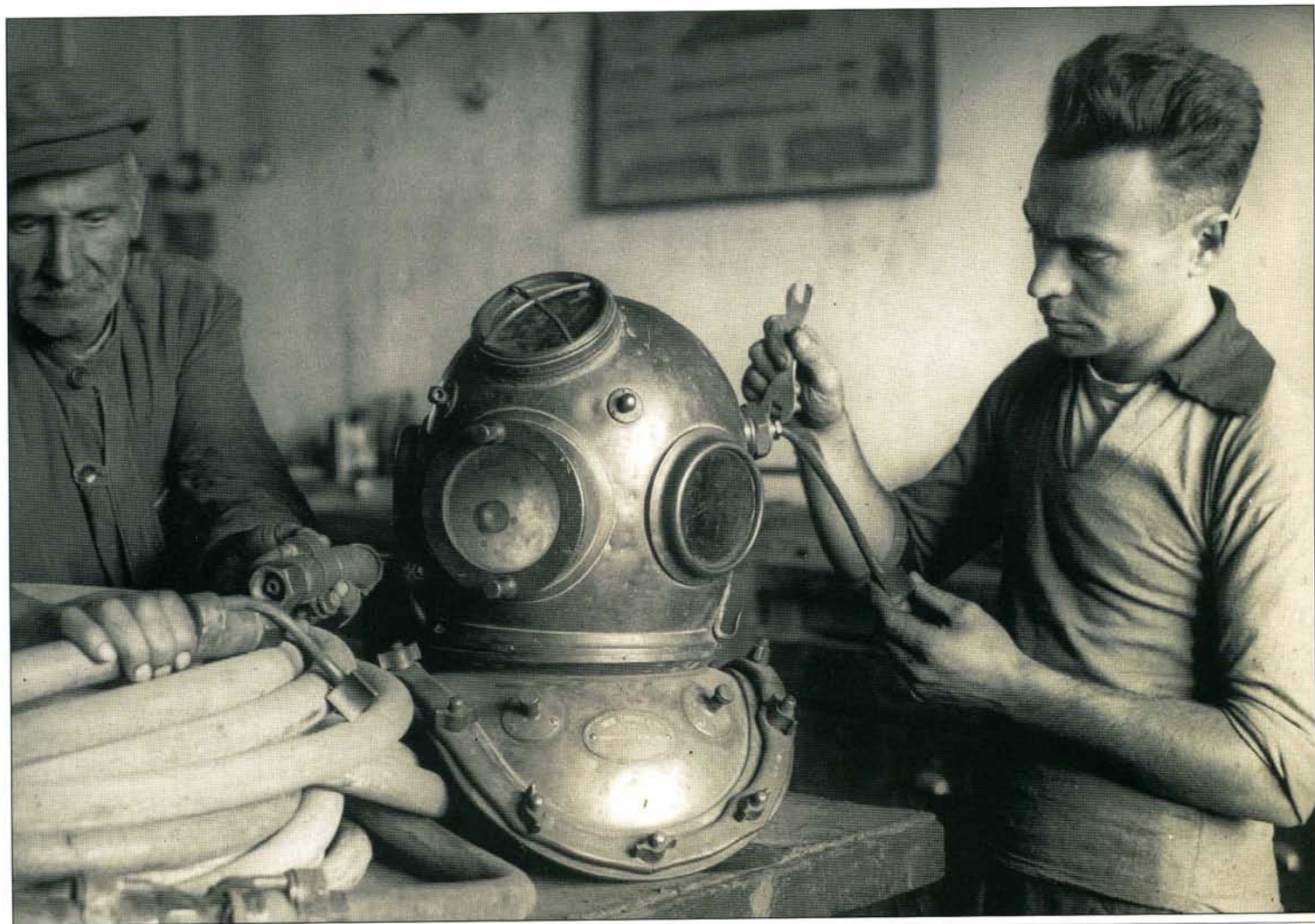
Техническое обслуживание водолазного снаряжения в Одесской партии ЭПРОНа (фото 1935 г.)
