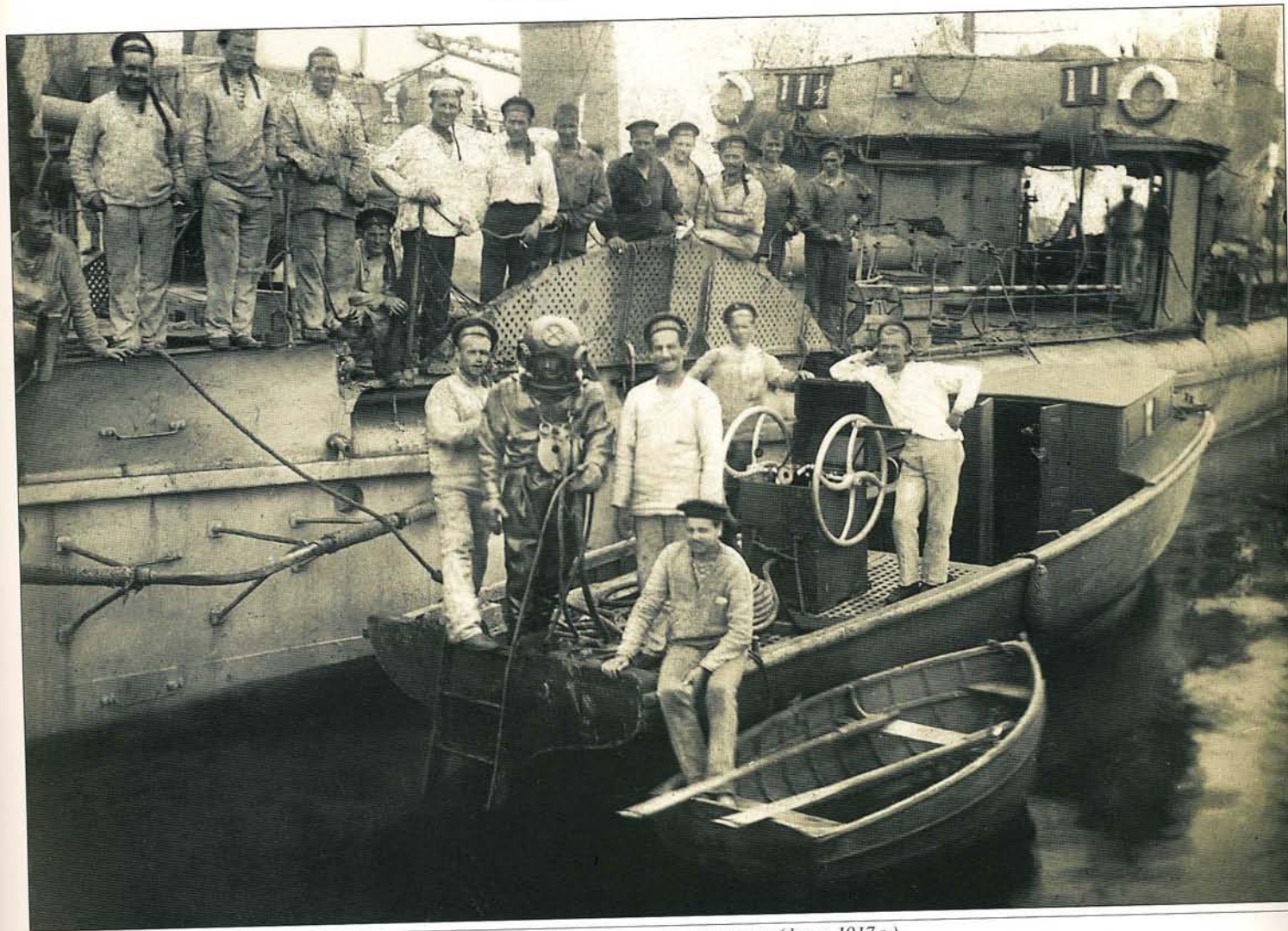
Водолазы на ремонте корпуса миноносца (фото 1917 г.)
