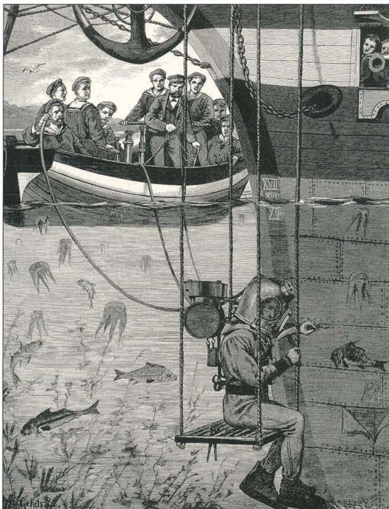
Ремонт подводной части корпуса судна без постановки в док (гравюра 1870-х гг.)
