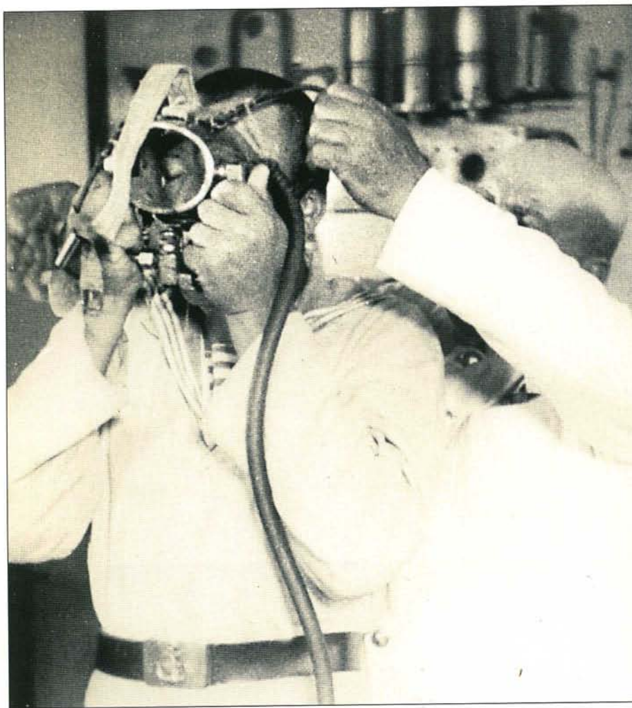
Рейдовая маска и облегченное водолазное снаряжение ОВС (фото середины 1930-х гг.)
