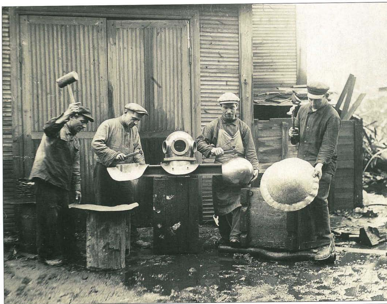
Изготовление водолазных шлемов мастерами ЭПРОНа (фото 1930-х гг.)
