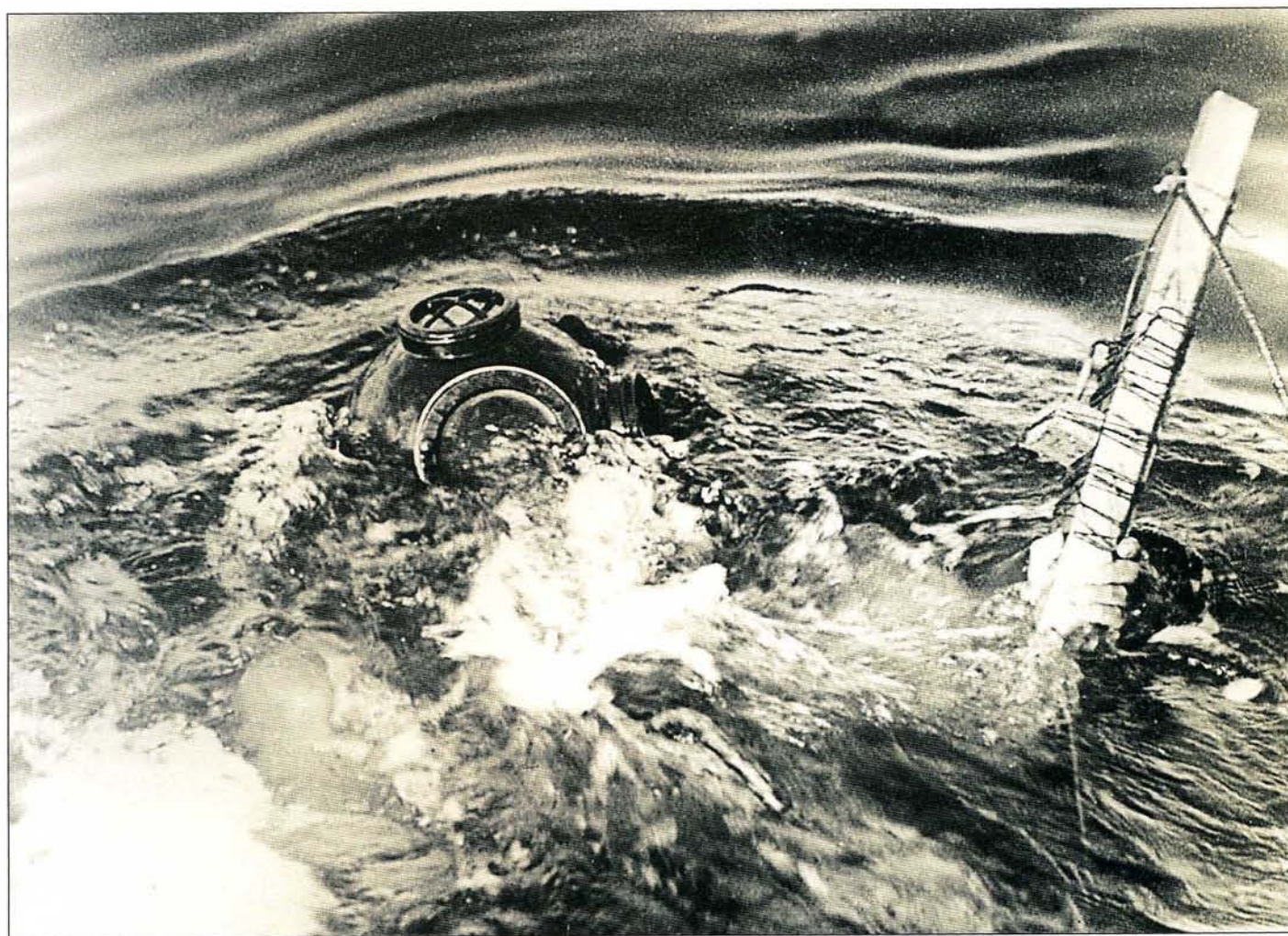
Водолаз ЭПРОНа с закрепленной на деревянной рейке толовой шашкой с электродетонатором (фото 1929 г.)
