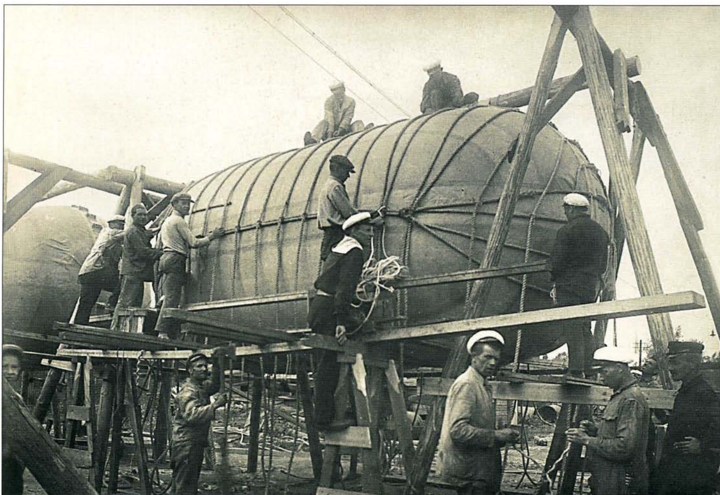
Обвязка мягкого понтона (фото середины 1930-х гг.)
