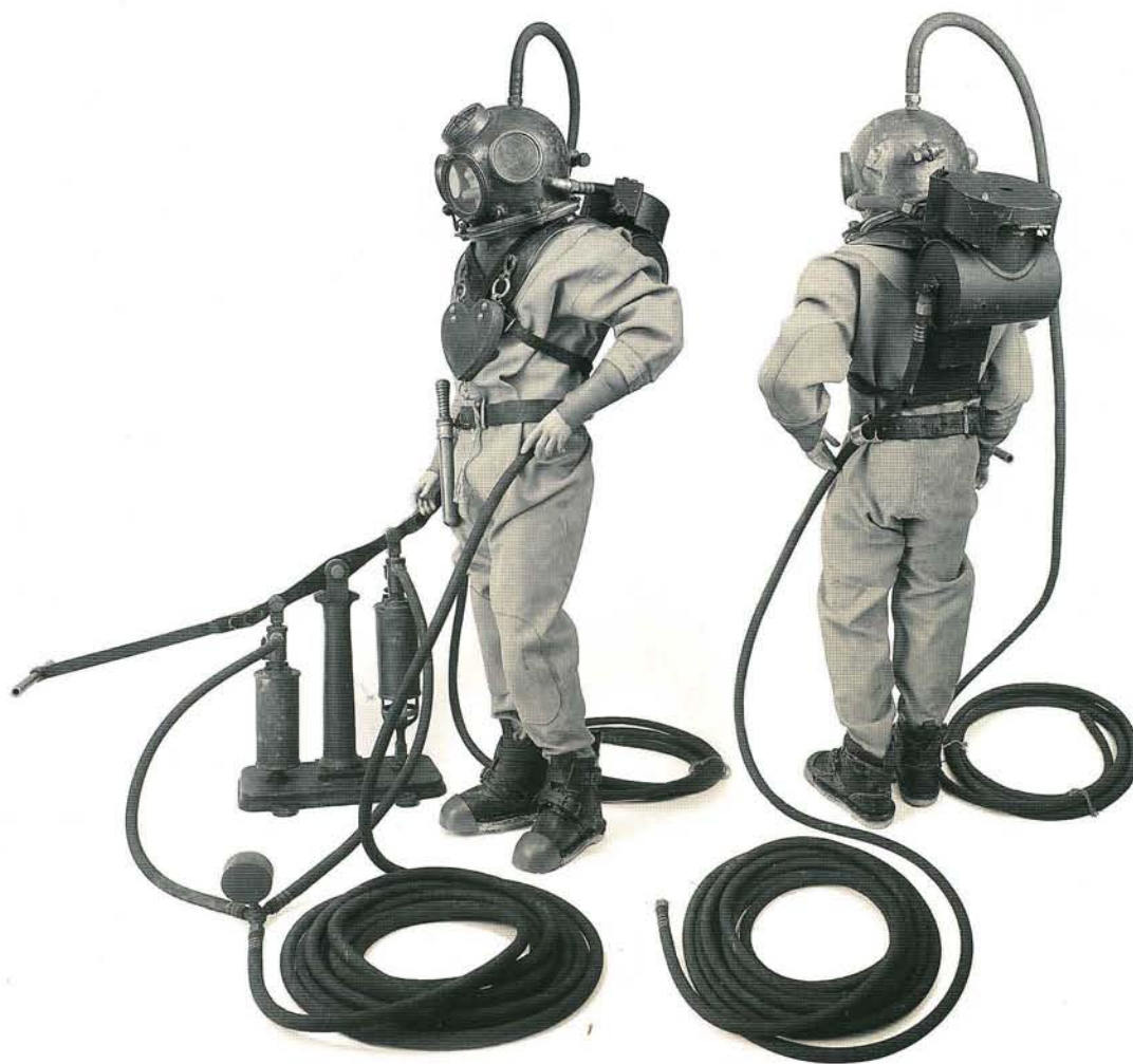
Трехболтовое снаряжение Денейруза образца 1872 г. (фото Д. Деккера 2007 г.)
