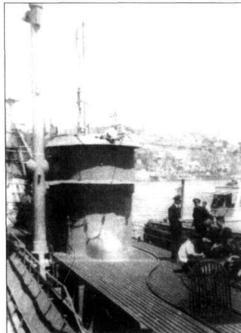
Ведутся работы со шнорхелем на подводной лодке IX серии в базе
