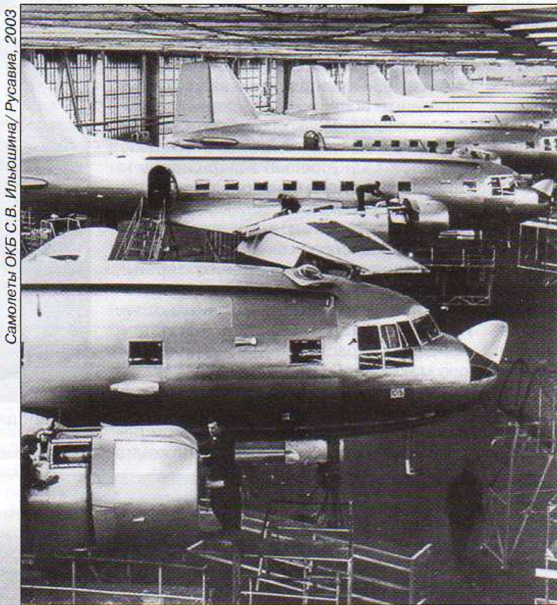
Сборка Ил-14 на авиазаводе № 30 The assembly of Il-14 of the Aircraft Plant No.30
