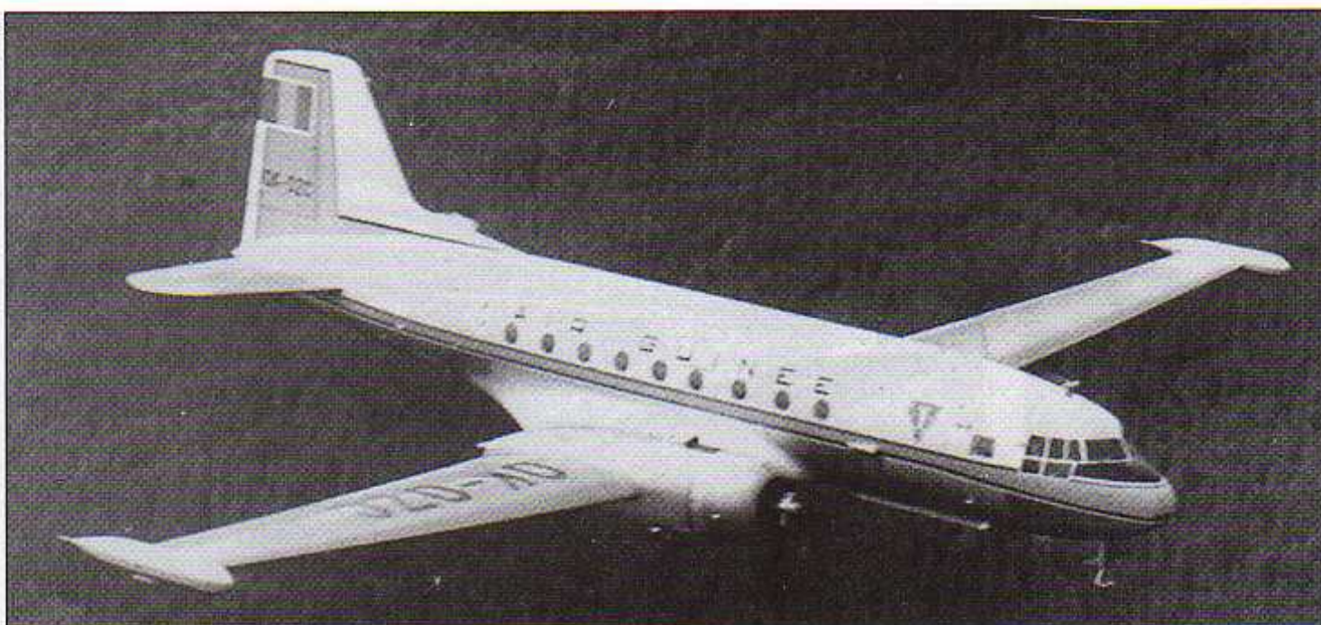
Пассажирский самолет с герметичным фюзеляжем Av-14Super Passenger aircraft with pressurized fuselage Av-14Super
