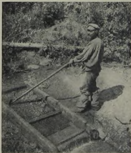
1. Гидравлическая разработка россылей (мониторы и элеваторы в работе). 2. Сплотка для подвоза воды на промывку (переброска воды через долину). 3. Разработка россылей. Вид драги со стороны ковшей. 4. „Старательская“ промывка золота на бутаре.
