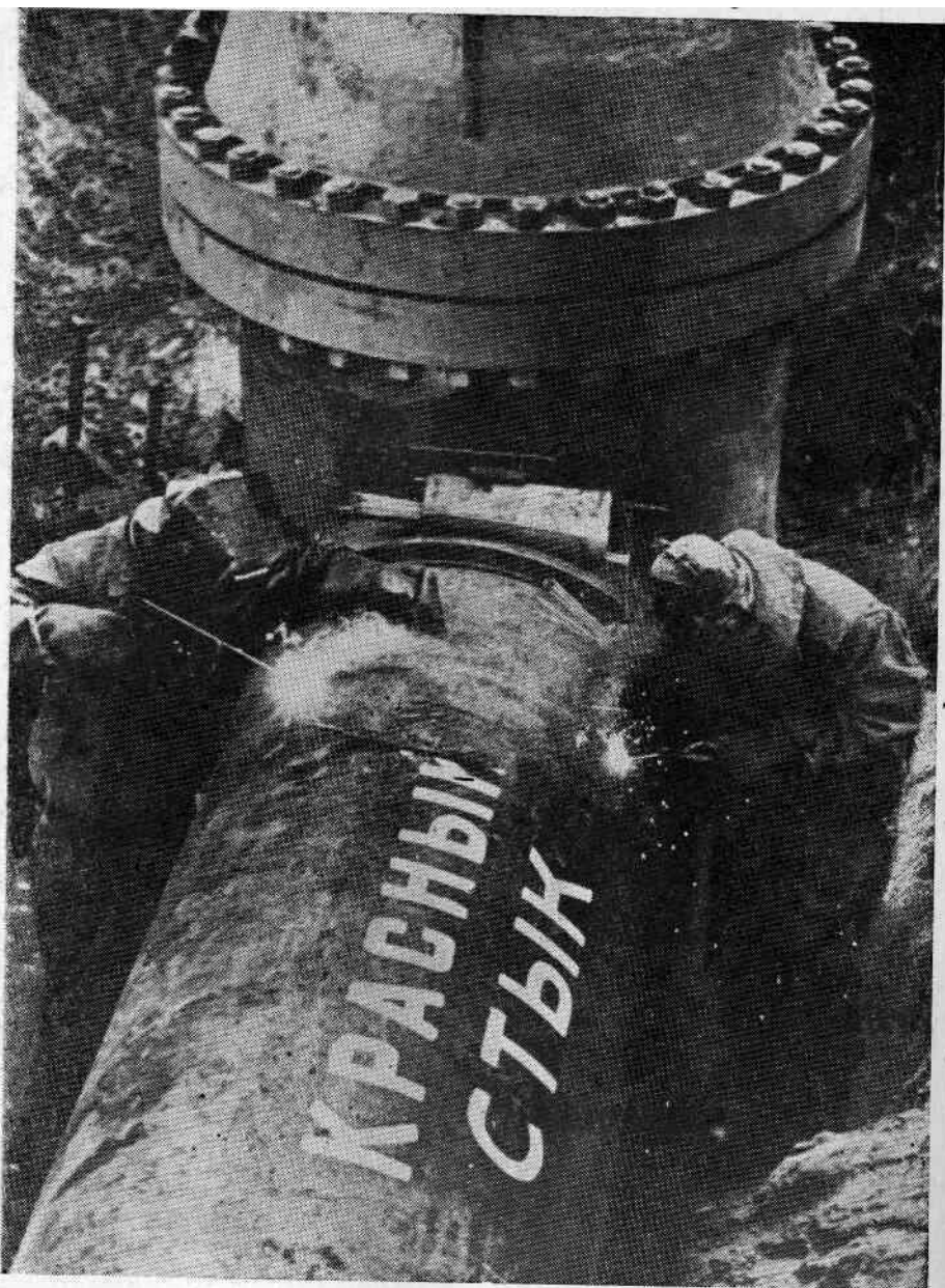
Нефтепровод Усть-Балык — Омск. Последняя сварка.
