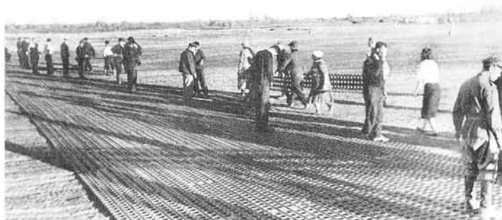
338. Укладка ленд-лизовских металлических плит на ВПП аэродрома Марково. Якутия. 1942 г.
