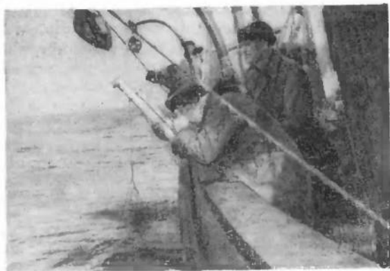
Работник станции производит отчет на глубоководном термометре
