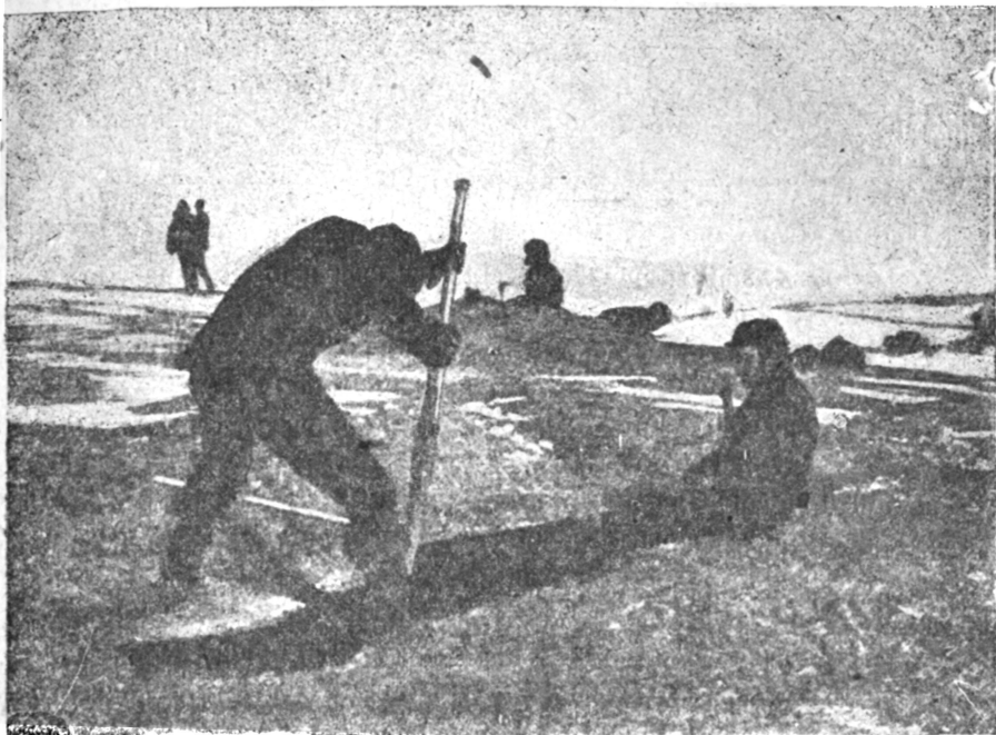
Рытье ям в вечно мерзлой почве для установки радиомачты
