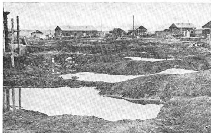
Рис. 11. Поселок, расположенный на суглинистых грунтах, содержащих подземные жильные льды. Их протаивание ведет к образованию просадок, оврагов, термокарстовых озер. Разжиженные грунты сползают по склонам и вниз по оврагу, увеличивая отрицательные формы рельефа.
