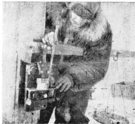
Испытание механических свойств льда на сжатие. У прибора А. И. Дубравин.
