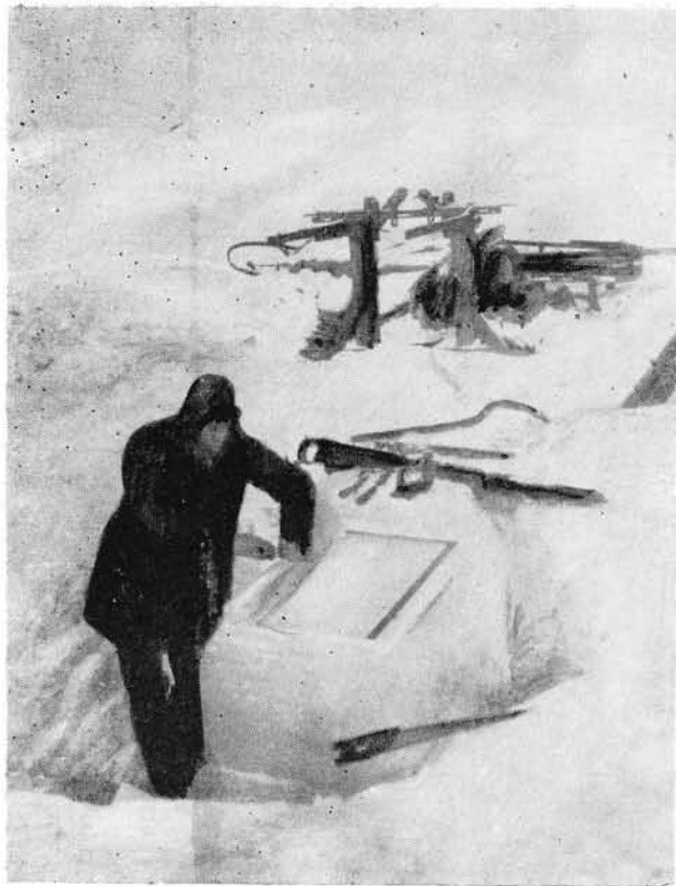
Изготовление образцов льда непосредственно из ледяного массива.
